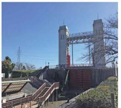
三栖閘門は伏見港と宇治川を結ぶ施設として昭和4年(1929)に造られた。2つのゲートで閘室内の水位を調整し、水位の違う濱川と宇治川を連続させて船を通す施設である。現在では交通路としての利用はされていない。構内には旧・三栖閘門操作室を復元した資料館 三栖閘門資料館がある。
